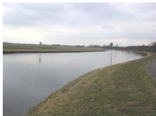
Deel Noord-Willemskanaal met damwanden
